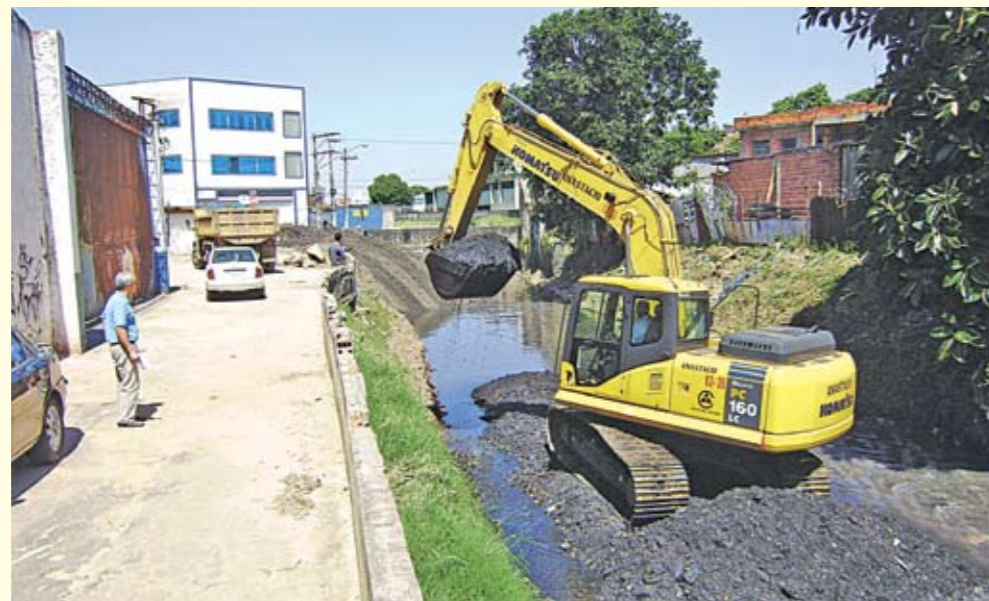
Escavadeira retira sujeira trazida pela chuva em um trecho do Córrego da Paciência
