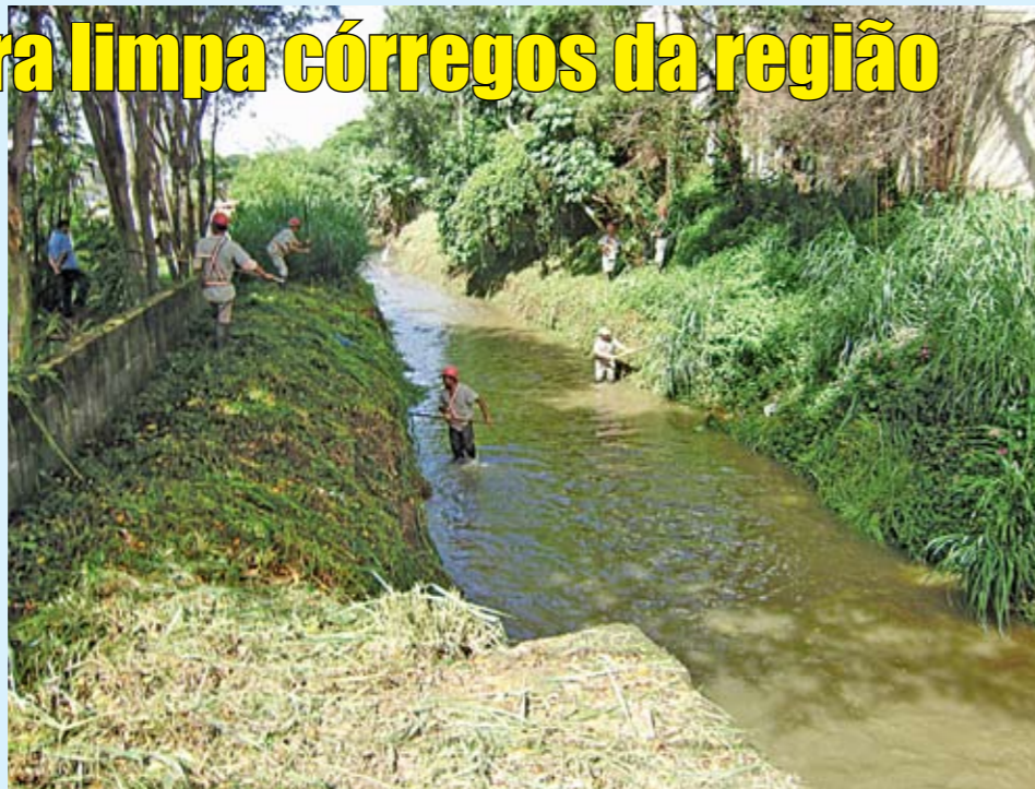
Córrego do Tremembé: limpeza manual por conta da largura estreita do local
