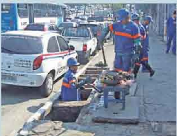
Limpeza manual de bocas-de-lobo: trabalho constante
