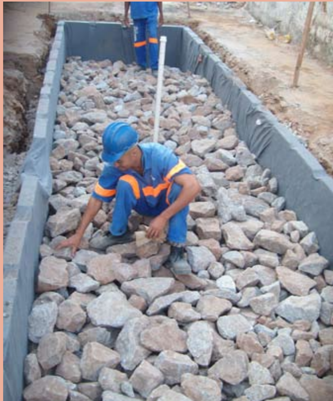
O reservatório dá tempo à água de se infiltrar na terra
