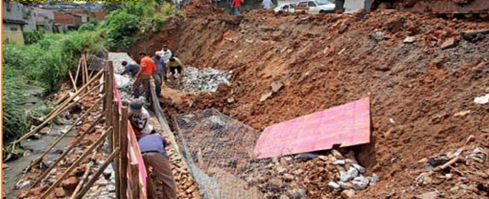
Muro de contenção: contra erosão e desabamento
