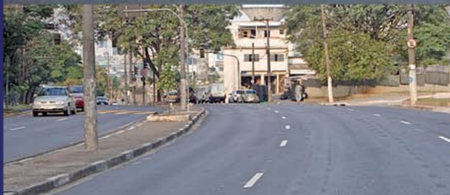
Avenida Almirante Delamare: recapeada e sinalizada
