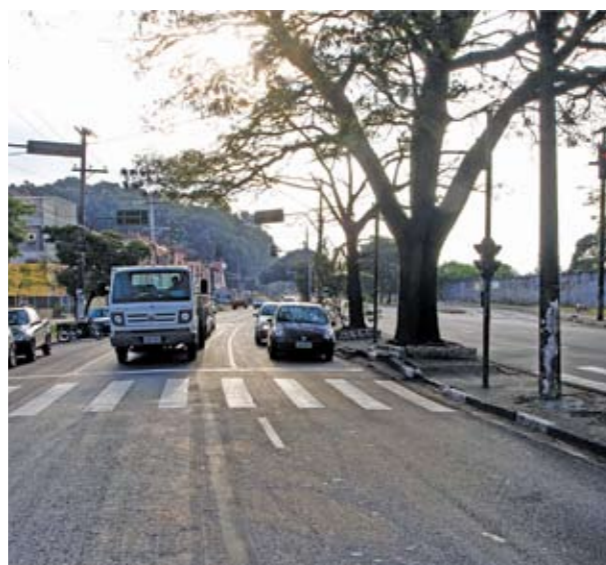
Avenida Almirante Delamare: 1.500 metros de recapeamento
