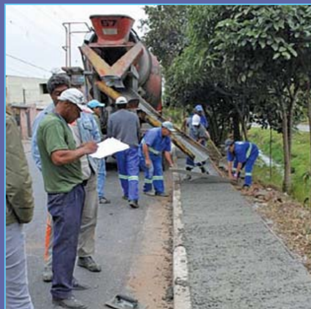
Obras na rua José Higino Neves: novo passeio
