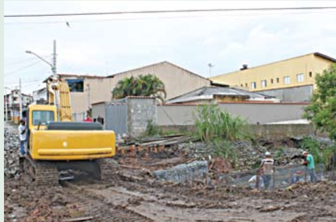
Máquinas trabalhando: rua Onça de Pitangui em obras
