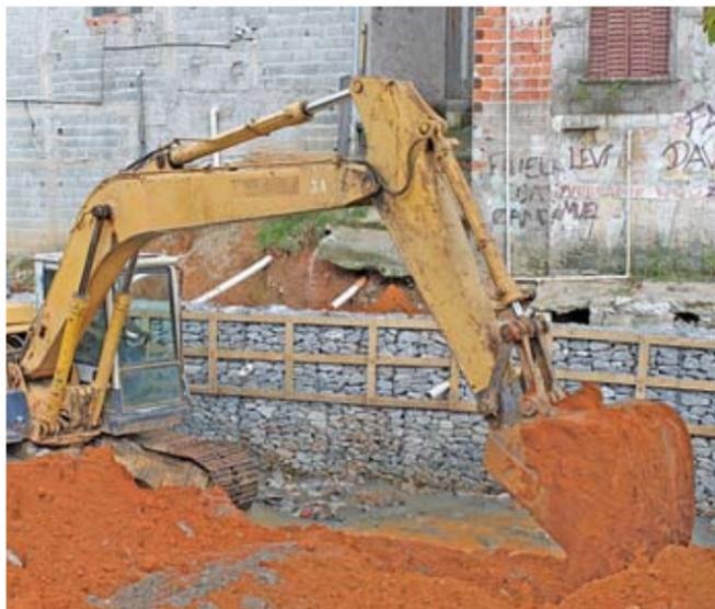
A obra da nova ponte: muro de contenção já ficou pronto
