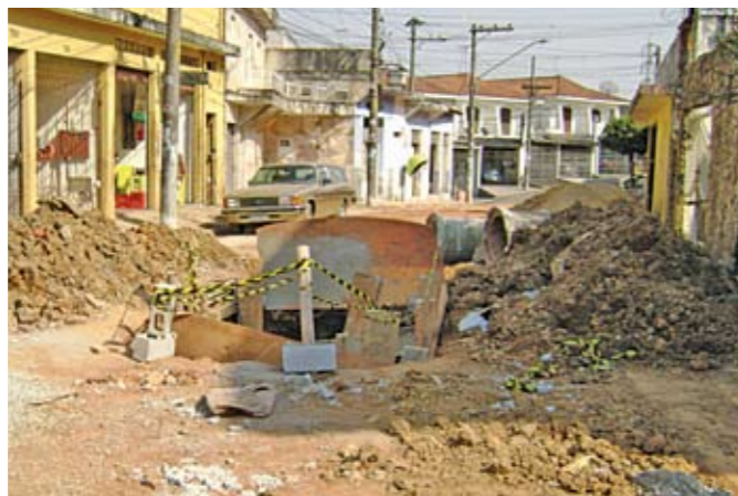
Contra enchentes: tubulações mais largas permitem melhor vazão
