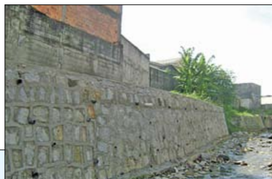
Rua Julieta Algorez: muro para evitar deslizamentos da margem
