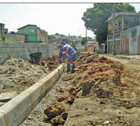
Av. Adelino: depois da construção de guias, sarjetas e do muro de contenção, virá o asfaltamento
