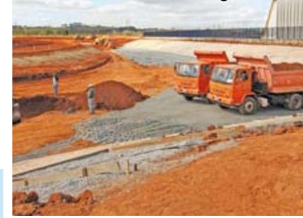
Para evitar enchentes no Jardim Romano, Zona Leste, a Prefeitura está construindo um dique numa extensão de quase 1 km, além de reservatórios que vão regularizar a vazão das águas do rio Tietê e implantação de sistema de microdrenagem
