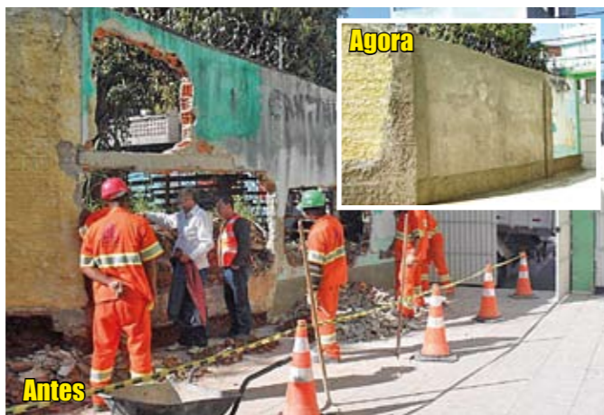
Rachaduras e buracos no muro da creche: consertados
