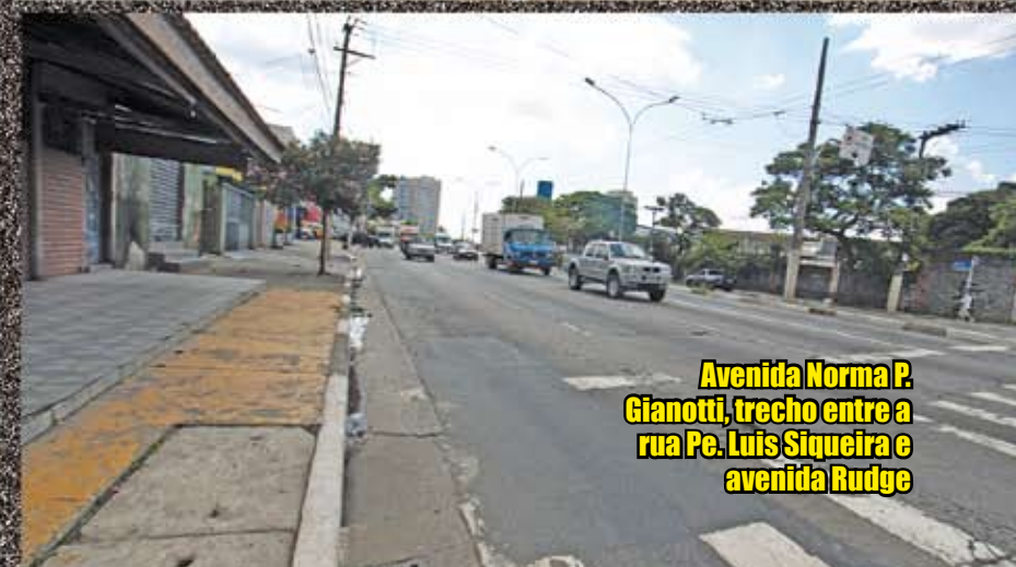
Rua Sérgio Tomás, trecho entre a av. Rudge e a marginal Tietê
