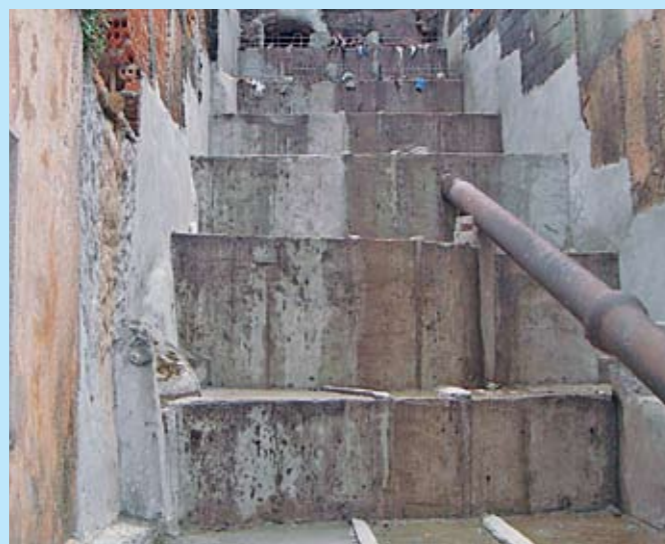
Escadaria para escoamento de água na rua Galeão São Vicente
