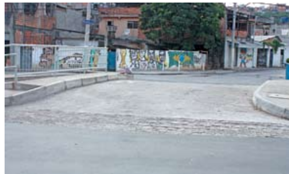
Ponte na rua Praia da Costa Verde: sobre o córrego
