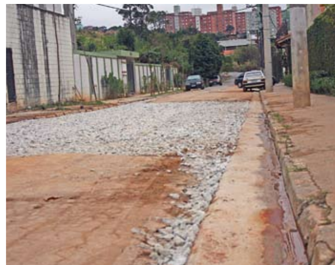
Rua Orlando Alvarenga Gáudio: obras para melhor
