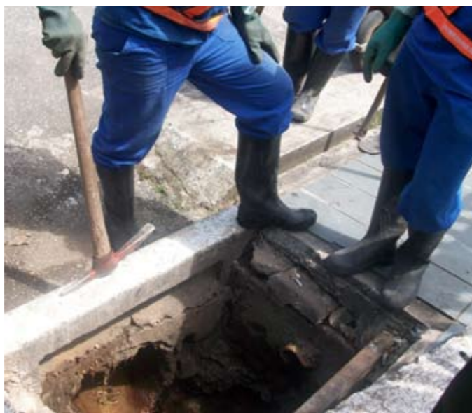
Limpeza de bueiro faz parte das ações da Operação Limpeza
