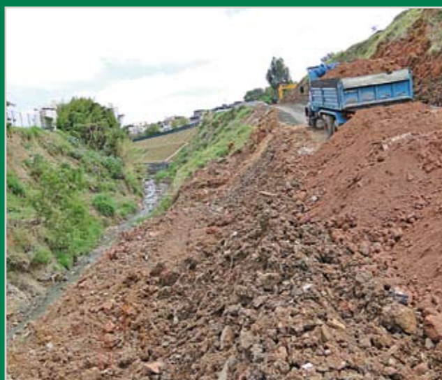
Obras de contenção: para evitar desmoronamento
