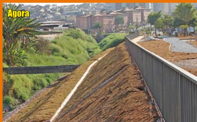
Para separá-la do terreno do parque linear, foi instalado um gradil em toda a extensão. O terreno do parque também passou por obras de drenagem, construção de passeios em concreto no entorno e passeios em pedriscos no interior. Foram colocados bancos e conjuntos de mesas e banquinhos em concreto aparente. Falta apenas terminar o plantio de grama, entre outros retoques finais.
