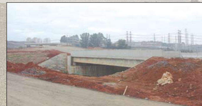
Cerca de 90% das obras estão prontas
