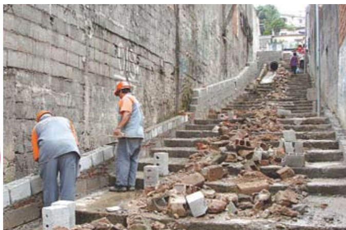
Além dos degraus, um muro está sendo erguido nas laterais
