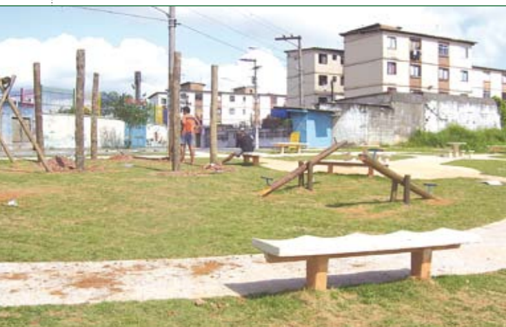
Praça da rua Nascer do Sol: obras para renovar equipamentos.
