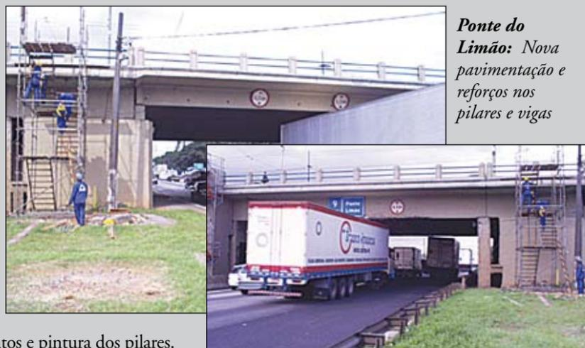
**Ponte do Limão:** Nova pavimentação e reforços nos pilares e vigas
