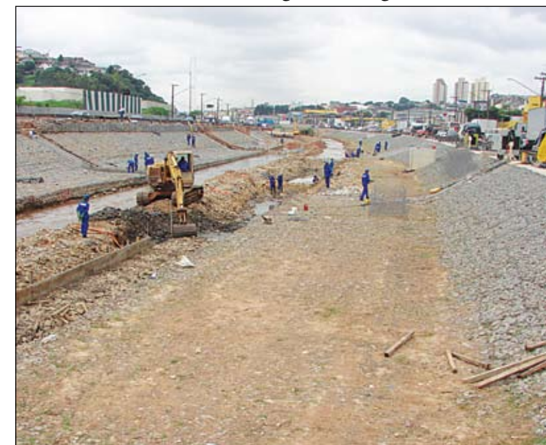
O Aricanduva: calha alargada, mais água escoada.
