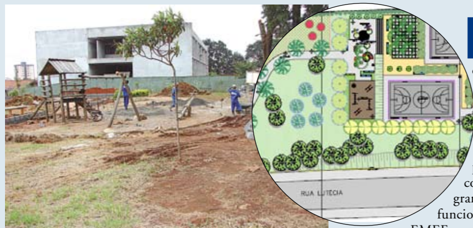
Ao lado da EMEF Lutécia, também em construção: um parque.
