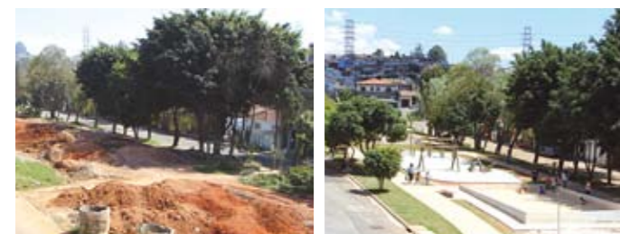
Sobre o córrego Uberabinha: as obras e a área de lazer pronta.
