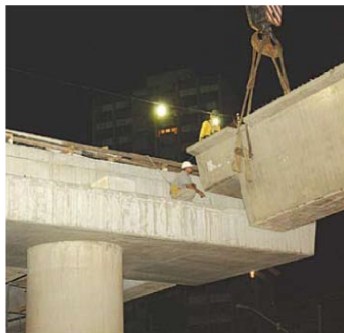
Cada viga pesa 140 toneladas e tem 33 metros de extensão
