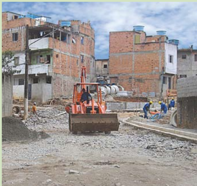
Vai começar: na rua de Paraisópolis, homens trabalhando
