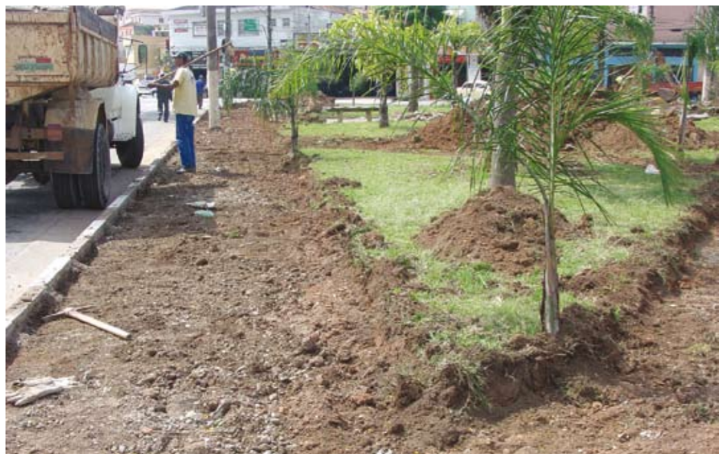
Praça dos Trotadores: em obras para receber novo piso, mais moderno e seguro
