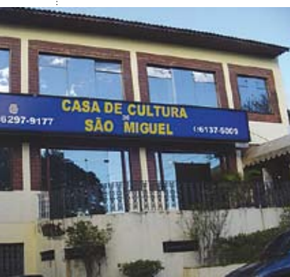
Casa de Cultura: em obras
