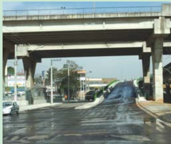
Pronto: alguns trechos da obra já estão concluídos
