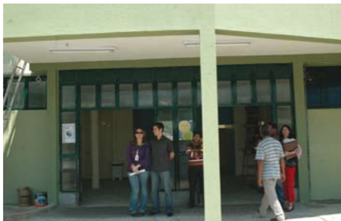
Mais conforto: reforma, pintura e equipamentos
