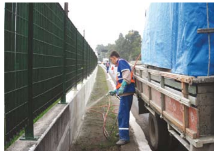
Pichação eliminada: operário pinta o muro
