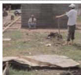
Centro: obras em curso
