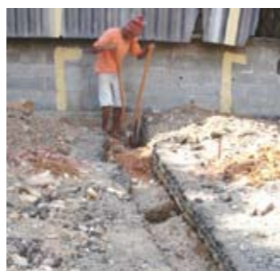
Ecoponto: já em obras
