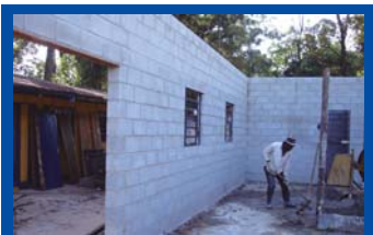
Novas instalações: alvenaria substituiu madeira
