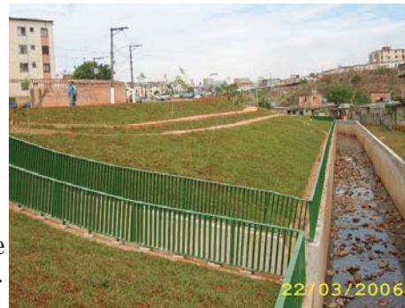
Nova face: canalização e drenagem.
