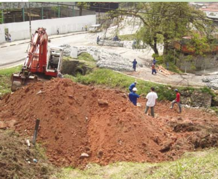
Máquinas trabalhando: o parque começa a aparecer
