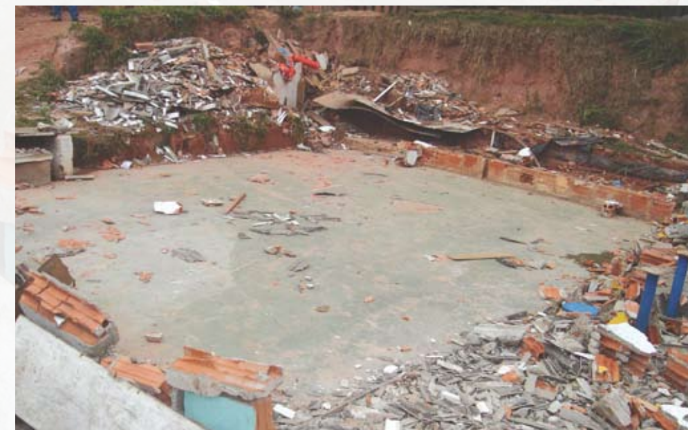
Área livre: ainda com entulhos, a área liberada pela Subprefeitura do Butantã
