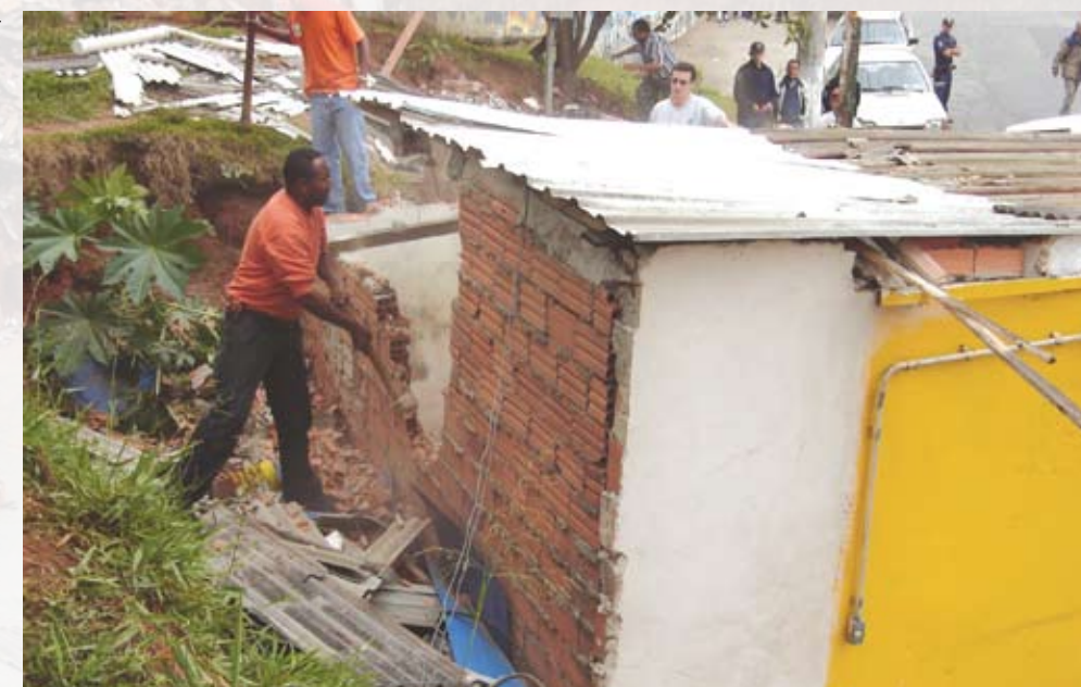
Retirada: funcionários da Subprefeitura fazem a remoção dos barracos irregulares
