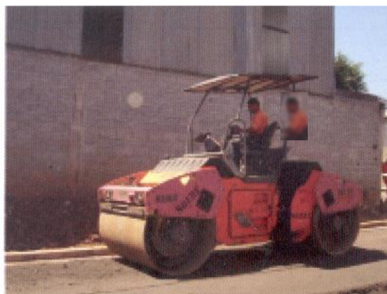
Compactação da base de RAP espumado
