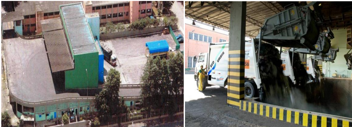
Fotos: Estação de Transbordo Vergueiro
