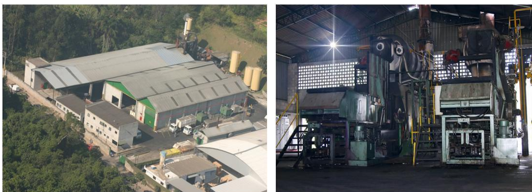
Fotos: incinerador Grupo B
