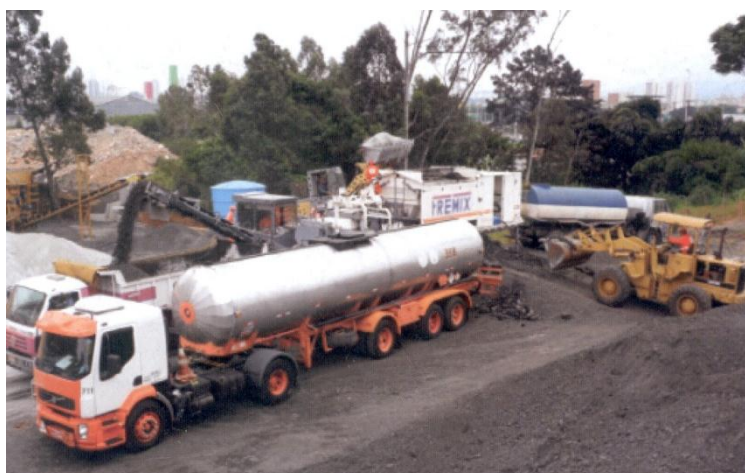
Foto: unidade de reciclagem de entulho e resíduos de misturas asfálticas “Júlio de Mesquita Neto”
