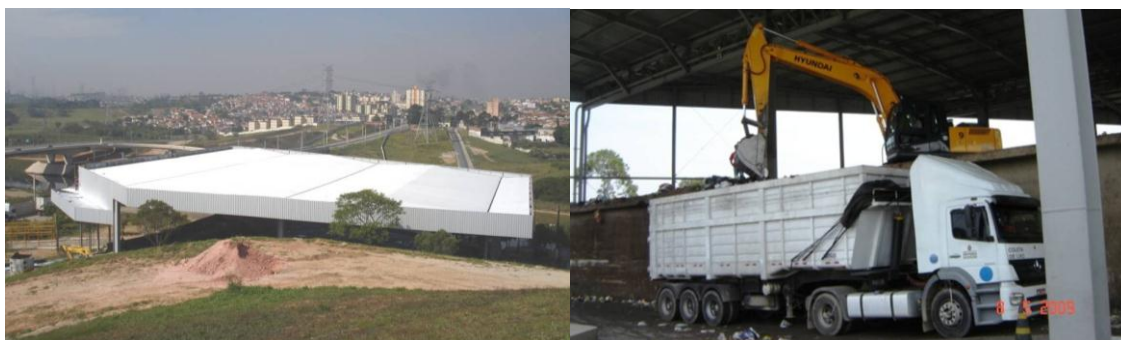
Fotos: Estação de Transbordo Santo Amaro
