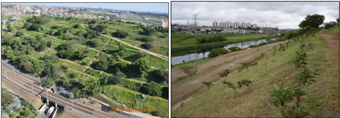
Fotos: revegetação do aterro desativado Santo Amaro
