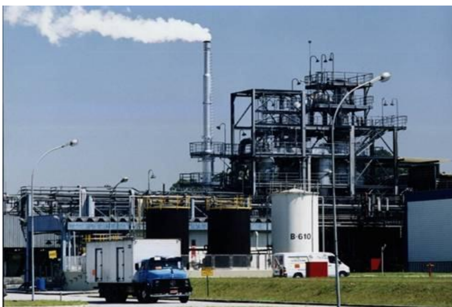
Foto: incinerador Grupo B perigoso
