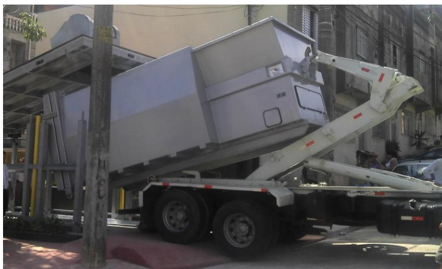
Foto: operação de remoção do contentor/compactador subterrâneo do bigtainer
