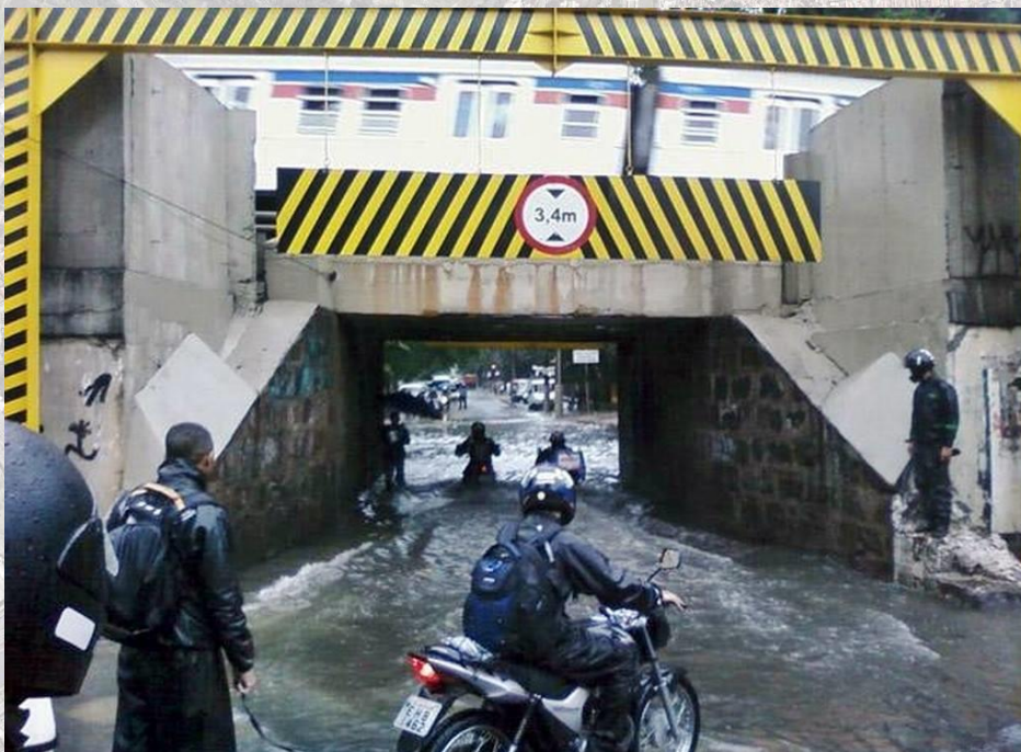
Alagamento na passagem inferior da Linha 8 – Diamante da CPTM.
