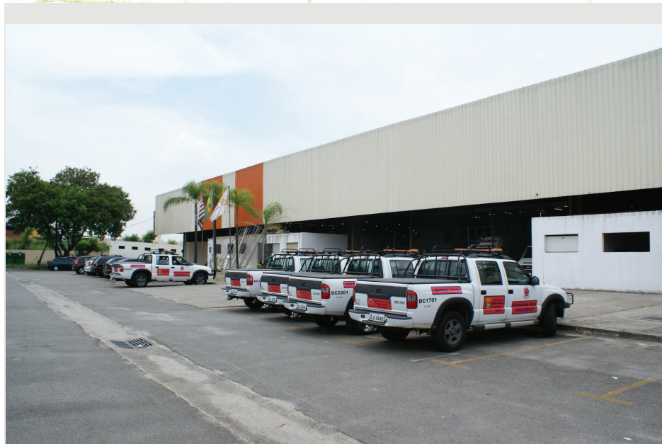
Nova Sede da Coordenadoria Municipal da Defesa Civil
