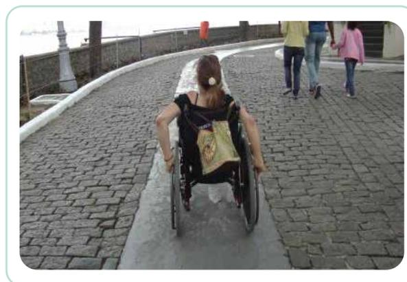
1a) ter superfície regular, firme, contínua, antiderrapante e que não cause trepidação em dispositivos com rodas sob qualquer condição;
