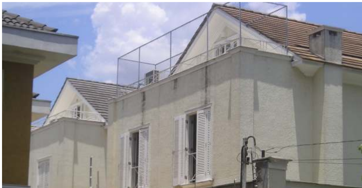
Terceiro andar existe (veja a grade); no entanto, o pavimento superior não foi "contabilizado" na planta aprovada
