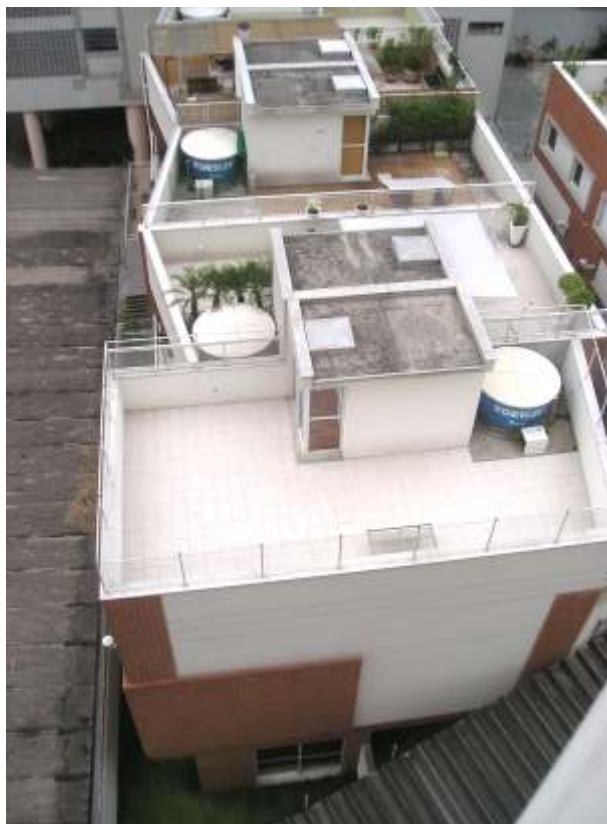
Cobertura de condomínio na rua Dr. Flaquer: quarto pavimento
