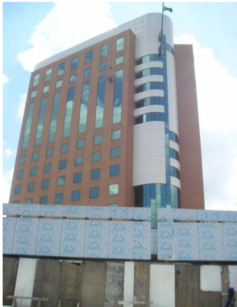
Vista do "Hotel" Bahamas, ainda com tapumes das obras: pedido irregular de anistia
