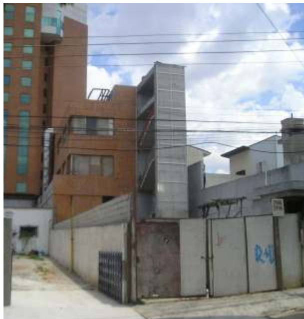
Obras no anexo ao Bahamas, em foto de fevereiro de 2006
