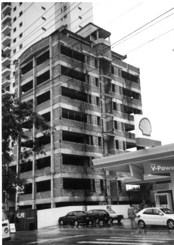
A estrutura do prédio, em foto do dia 21 de janeiro último: as obras estão embargadas pela prefeitura
