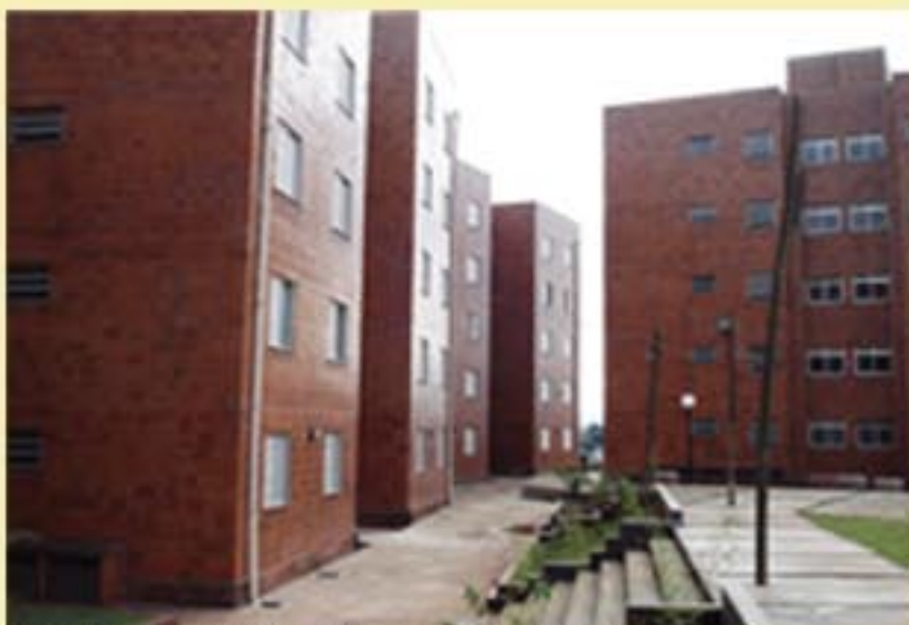
Construção de 120 unidades habitacionais
