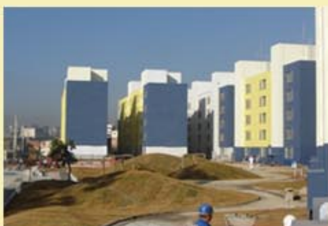
Construção de unidades habitacionais
