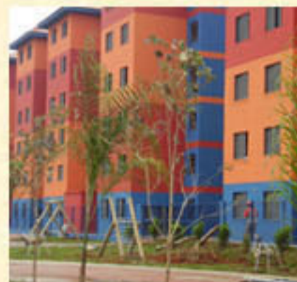
Construção de 96 UHs
