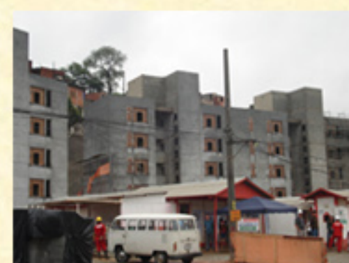
Obras em andamento
