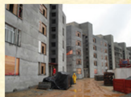
Obras em andamento
